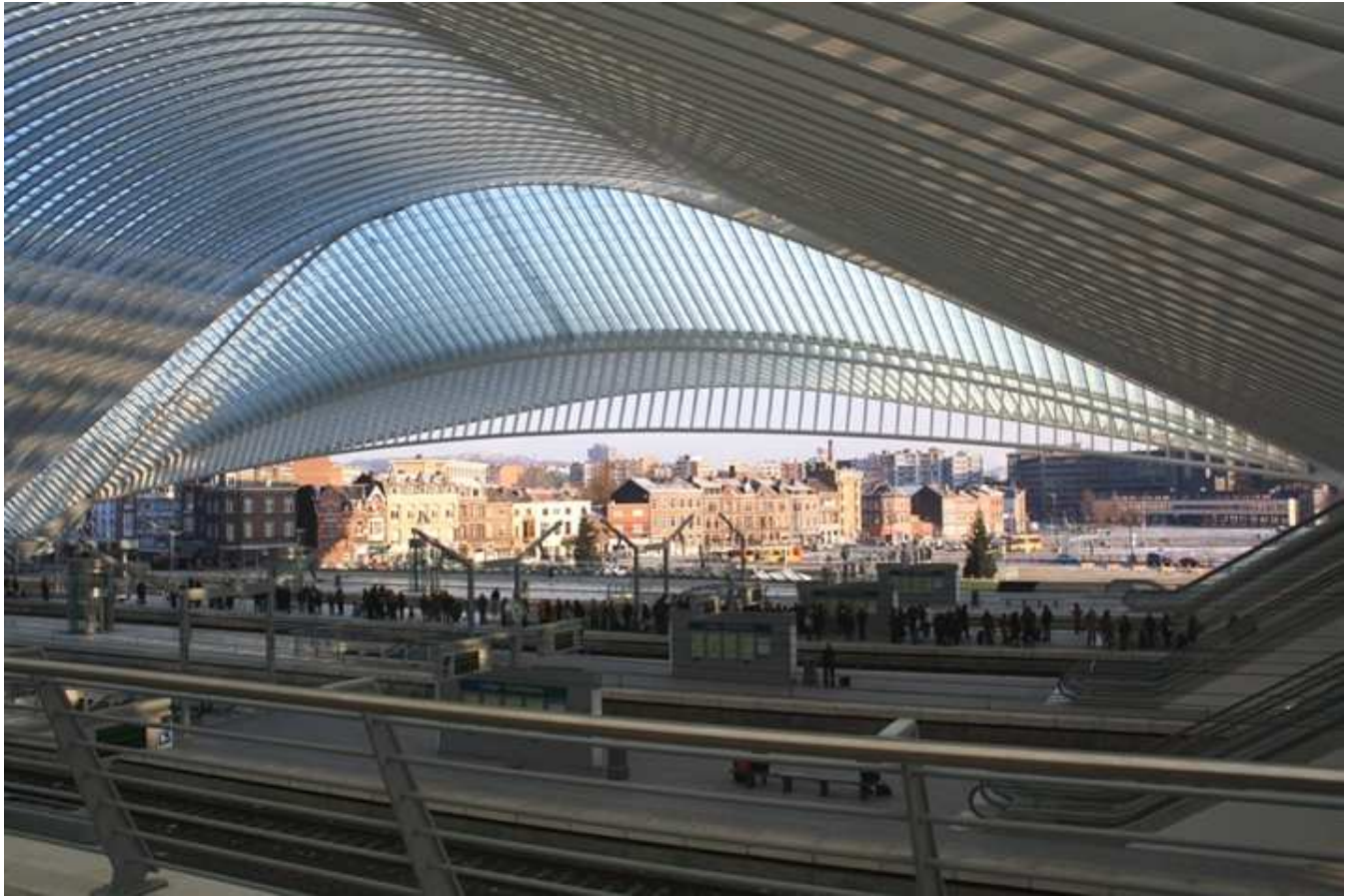
Der Bahnhof Lüttich-Guillemins
