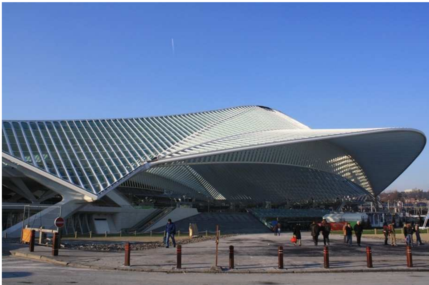
Der Bahnhof Lüttich-Guillemins
