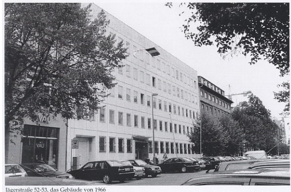
Jägerstraße 52-53, das Gebäude von 1966
